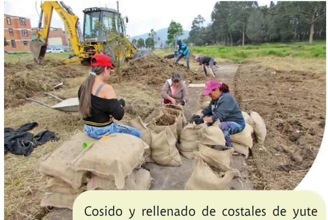
Cosido y relleno de costales de yute con tierra y residuos obtenidos del descapote, que fueron apilados en tres hileras para contribuir a la contención de la pendiente de la terraza alta de la ronda reconformada.
